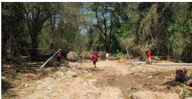
Foto 17. Isipotindi. Sistema de agua para consumo averiado por la riada
